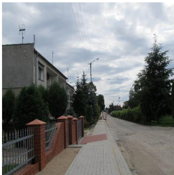
Wymiana oświetlenia ulicznego
