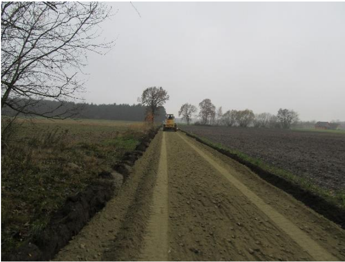
Przebudowa drogi Pieruchy - Pieruszczycki – nakładka tłuczniowa
