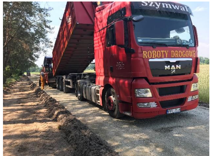
Przebudowa drogi Pieruchy - Pieruszczycki – nakładka tłuczniowa
