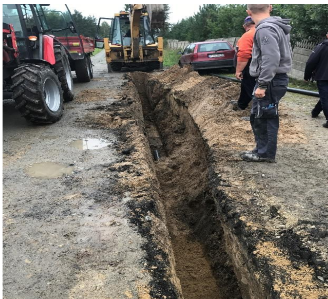
Przebudowa sieci wodociągowej
