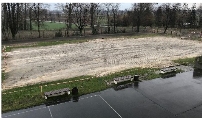
Wykonanie melioracji pod boisko
